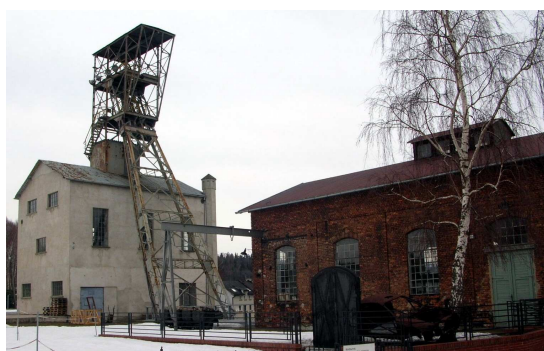
Rys. 2. Budynek nadszybowy z wieżą oraz budynek maszyny wyciągowej szybu Teresa, stan obecny
