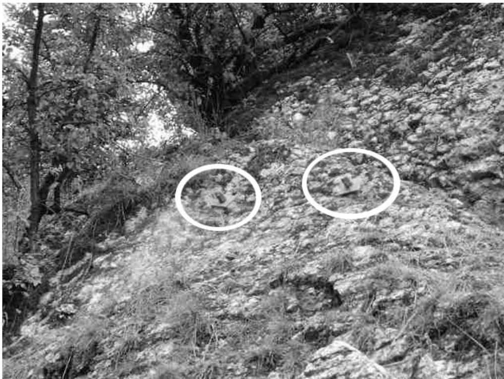
Rys. 4. Widoczne końcówki kotew z podkładkami i nakrętkami, spinające płyty tworzące ocios południowy jaskini
