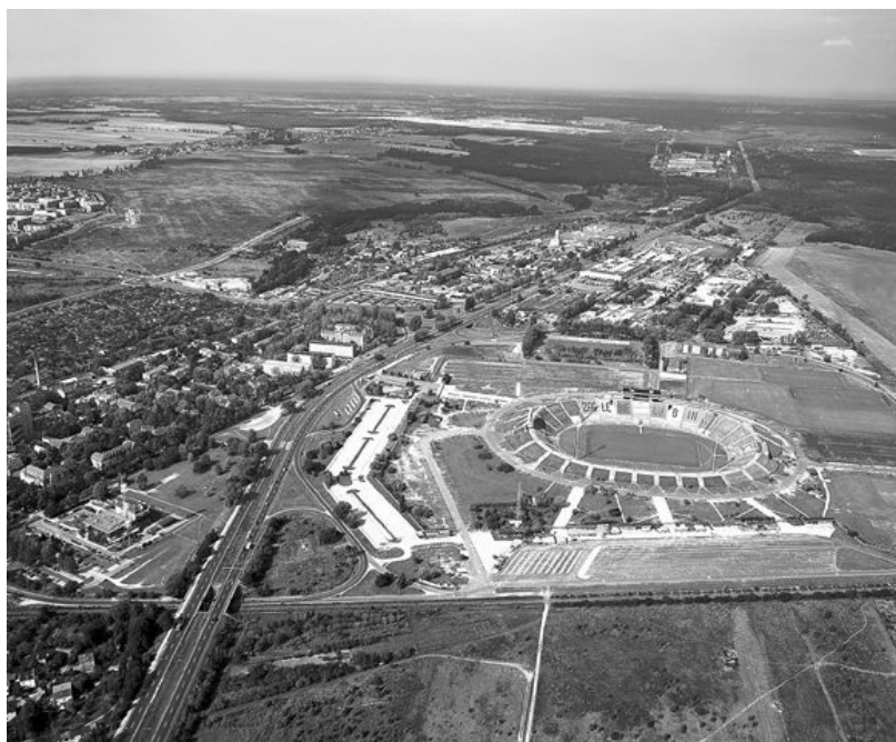
Rys. 7. Panorama północnej części Lubina: stadion Zagłębia Lubina, w głębi szyby ZG „Lubin”.
