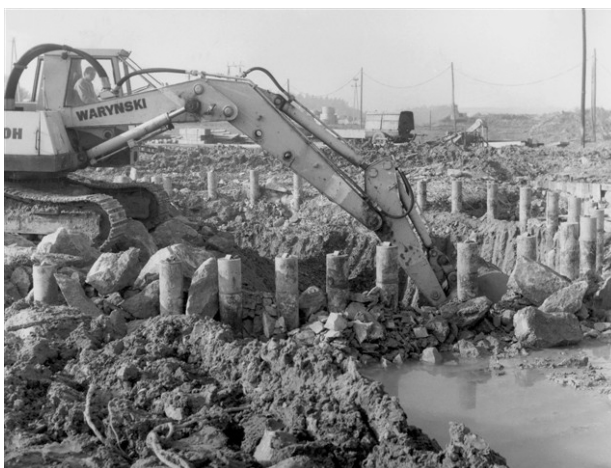
Rys. 3. Pierwsze prace przy budowie szybu SW-1
