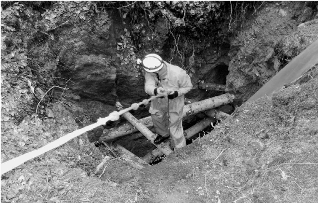
Rys. 4. Odkopany górny szyb
