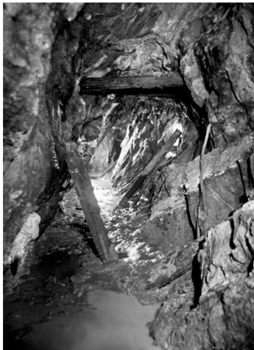
Rys. 5. Początkowy odcinek korytarza sztolni
