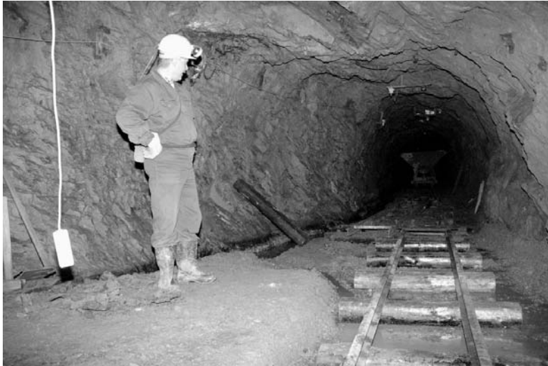
Fot. 3. Układanie torowiska do wywozu urobku
