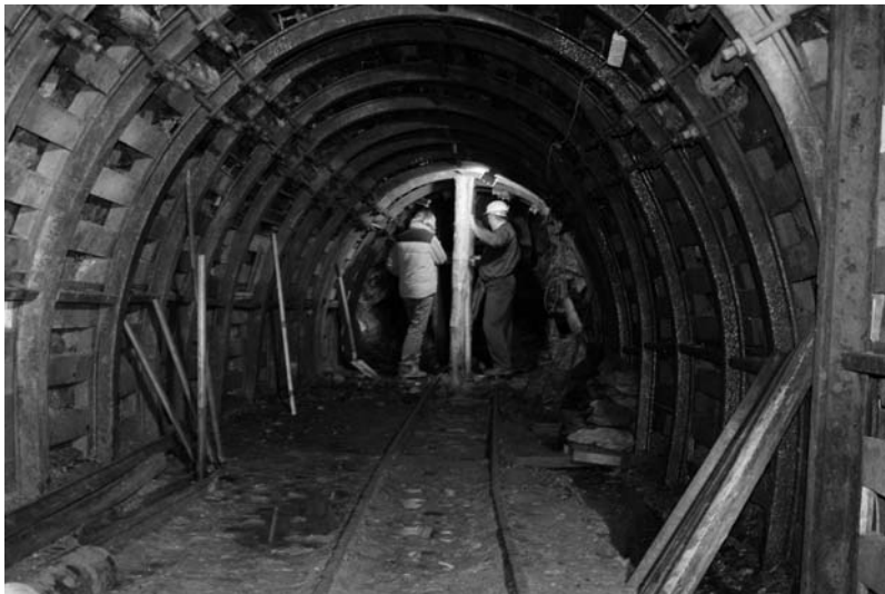
Fot. 4. Połączenie nowo kładzonego torowiska ze starym, niemieckim
