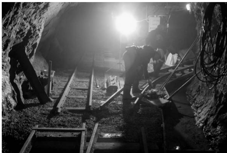
Fot. 5. Zmiana rozstawu torowiska z 500 mm na 600 mm
