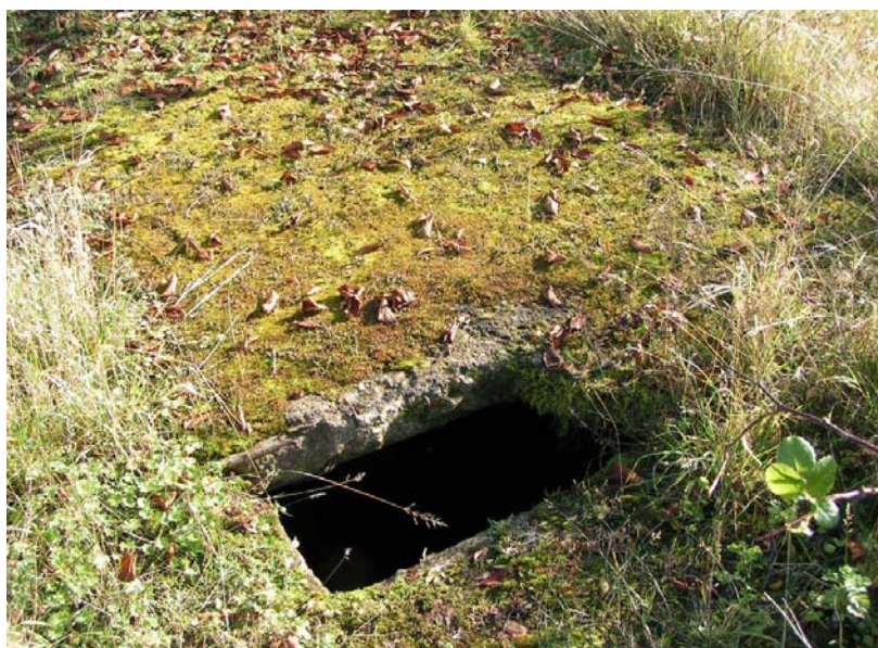
Rys. 9. Płyta betonowa zamykająca szyb „Graf Hochberg”
