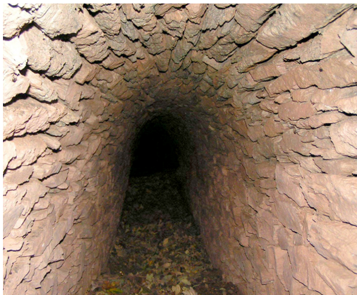
Rys. 11. Obudowa kamienna początkowego odcinka sztolni „Carl” (stan obecny)
