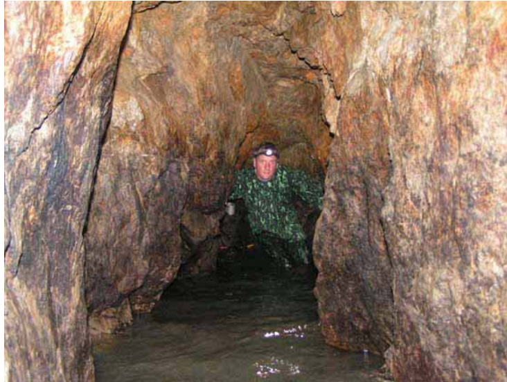
Rys. 8. Duże wymiary przekroju poprzecznego sztolni „dolnej” (widoczny na fot. M. Mieszkowski stoi na pozostałościach drewnianego pomostu w dolnej części sztolni)
