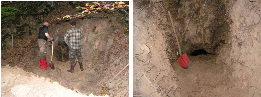
Rys. 4, 5. Prace zmierzające do ponownego udostępnienia sztolni „dolnej” (fot. A.Florek)
