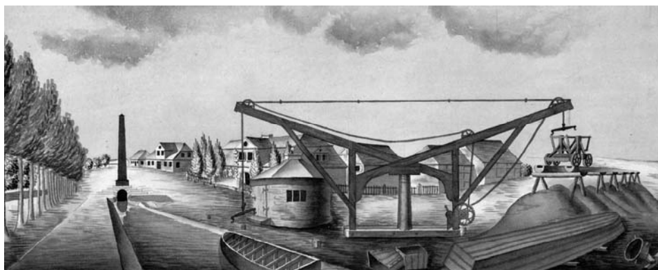
Rys. 11. Port przeładunkowy przy wylocie sztolni Fig. 11. Reloading port next to the outlet of the adit
