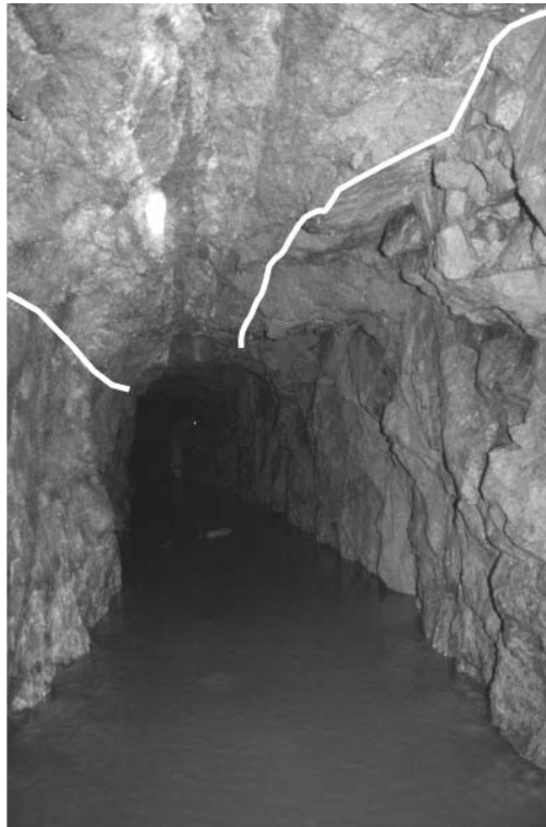
Rys. 4. Główna strefa tektoniczna widoczna w stropie wyrobiska – sztolnia wejściowa
