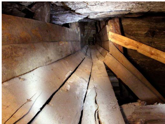
Rys. 8. Suwaczka przy podłużni Sienkiewicz na III poziomie
