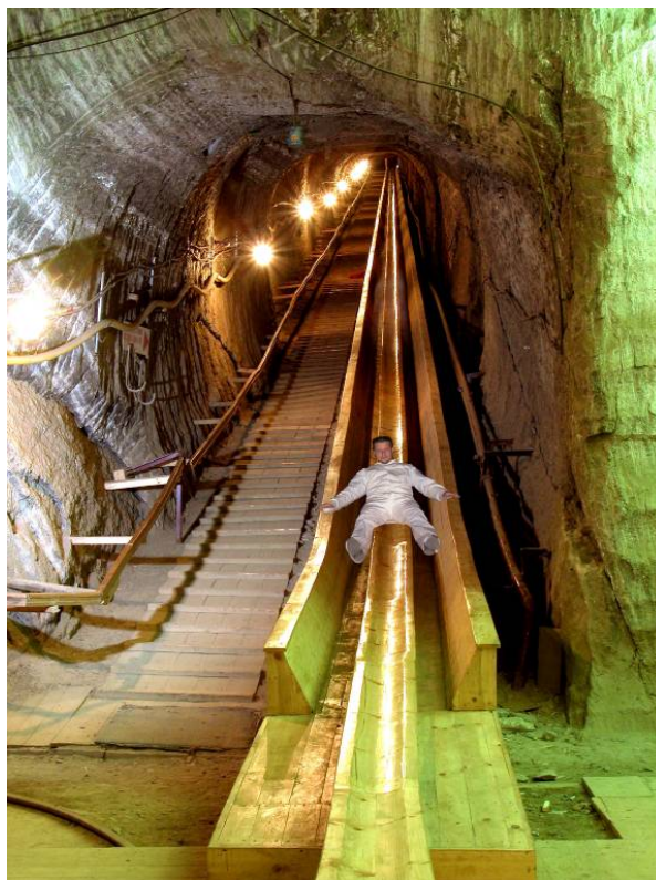
Rys. 9. Zjeżdżalnia w upadowej z poziomu I August do komory Ważyn
