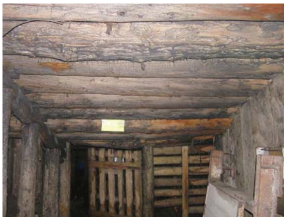
Fot. 2. Podszybie poziom I
