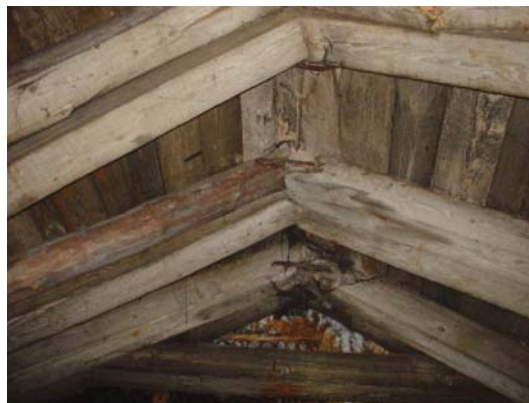
Fot. 4. Podszybie poziom III Photo. 4. Pitbottom at level III
