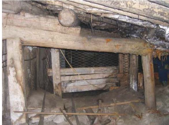
Fot. 3. Podszybie poziom II Photo. 3. Pitbottom at level II
