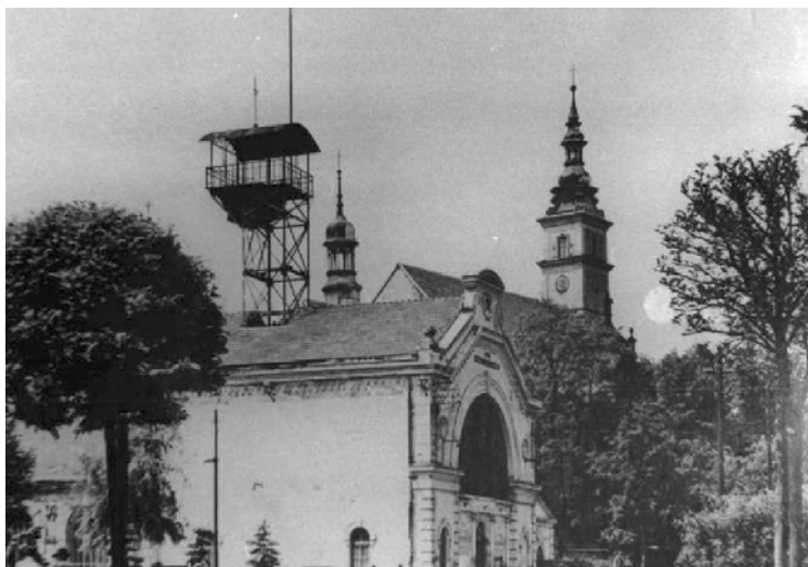
Fot. 1. Nadszybie szybu „Regis” od strony wschodniej (widok po roku 1945). Photo. 1. „Regis” shaft top from E (after 1945)
