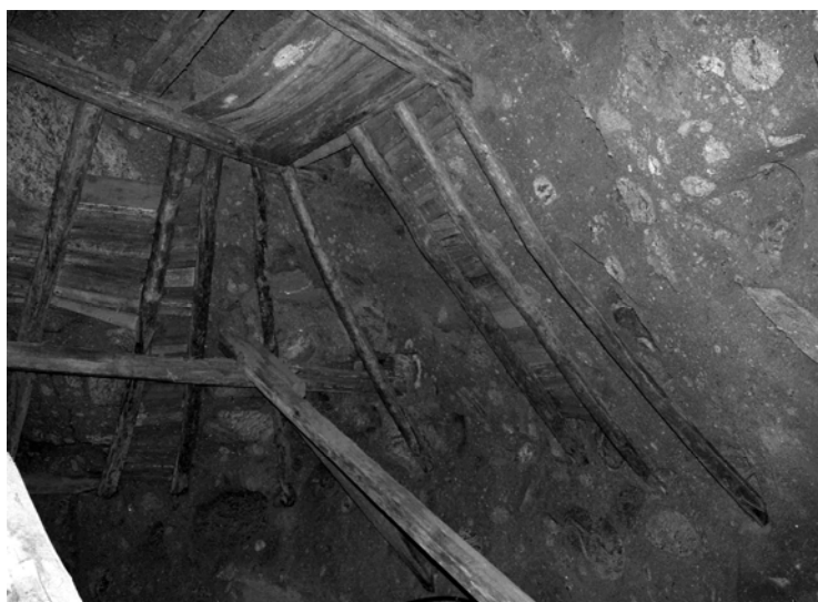
Rys. 6. Fragmenty zniszczonej obudowy koszykowej komory oraz odsłonięcia skał płonnych (zubrów) (ze zbiorów archiwum KGHM CUPRUM)
