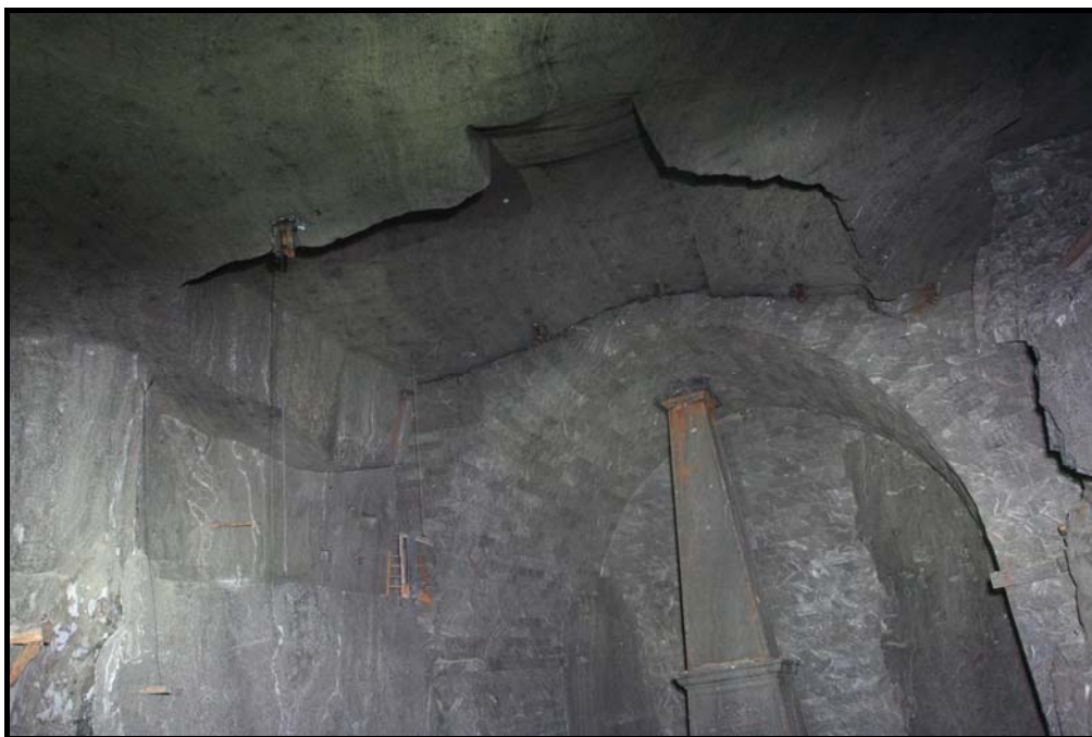
Rys. 5. Komora Franciszek Karol – część południowa (fot. A. Maj, 2009)
