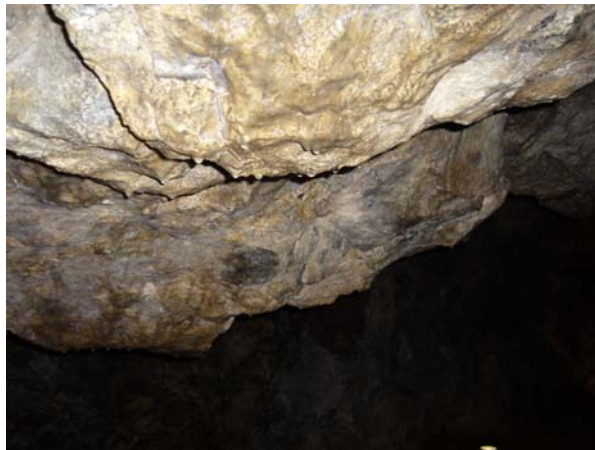
Rys. 9. Wykroplenia ze stropu Fig. 9. Outdropping from the roof
