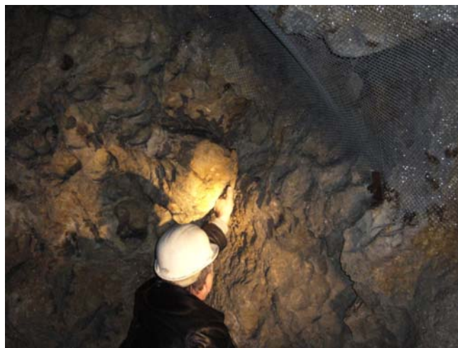
Rys. 8. Spękane i częściowo spojone bloki skalne wraz z siatką zabezpieczającą
