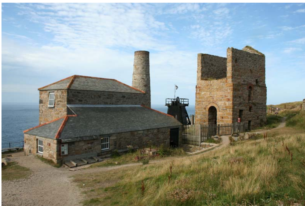
Fot. 2. Maszynownie kopalni Levant (Kornwalia)
