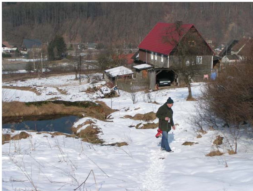
Rys. 14. Wypływ wody z zawalanej sztolni „Antoinette”
