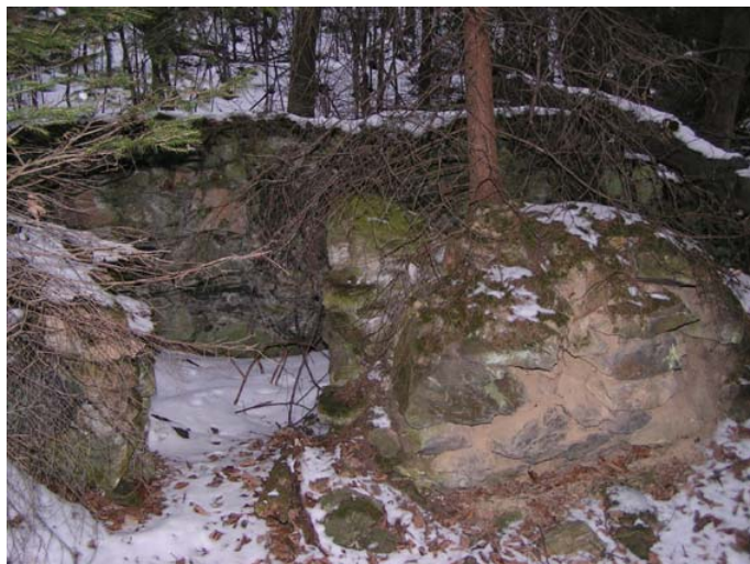
Rys. 22. Pozostałości zabudowań huty w Ciechanowicach z XVIII w.
