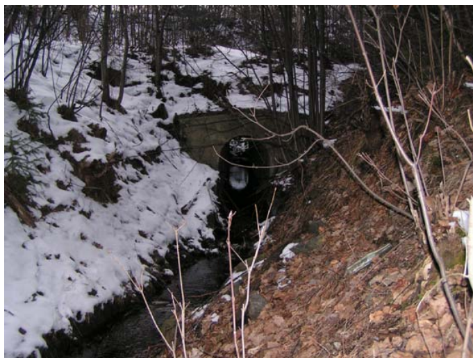
Rys. 15. Wypływ wody ze sztolni „Miedziankowskiej” (ujęty w przepuście pod nasypem kolejowym)
