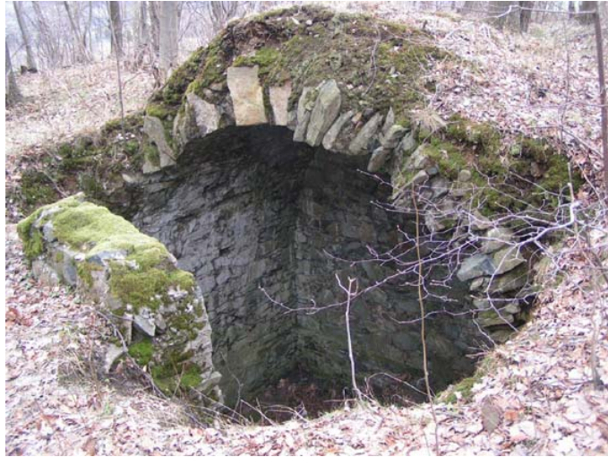
Rys. 23. Pozostałości zabudowań przy szybie „Neu Adler”
