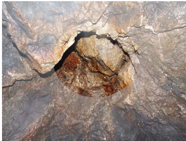
Rys. 8. Głaz zamykający obecnie szybik wentylacyjny nad szybem pochyłym
