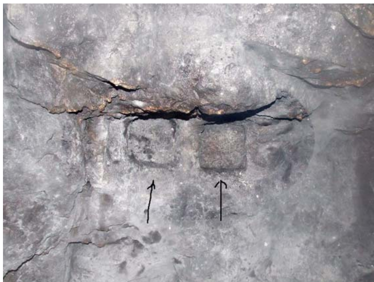
Rys. 9. Gniazda belek nad szybem ślepym
