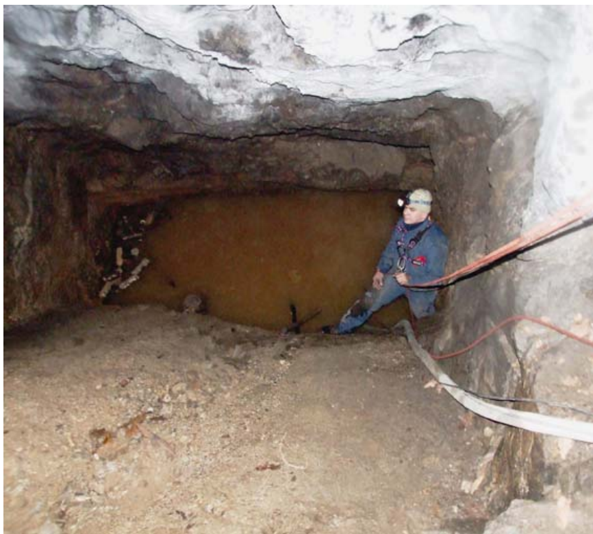
Rys. 3. Wypełniony wodą ślepy szyb pochyły w spągu sztolni
