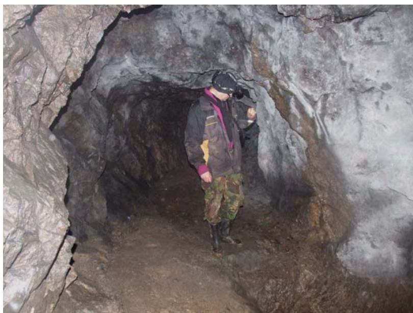
Rys. 4. Poszerzony odcinek sztolni przy zrębie szybu pochylego
