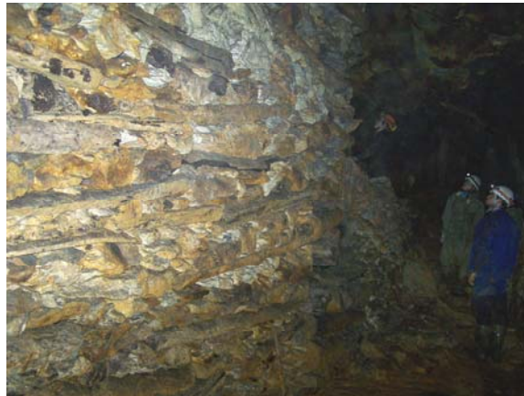
Rys. 6. Kamiennieo-drewniany kaszt zbudowany w komorze (fot. W. Mišta)
