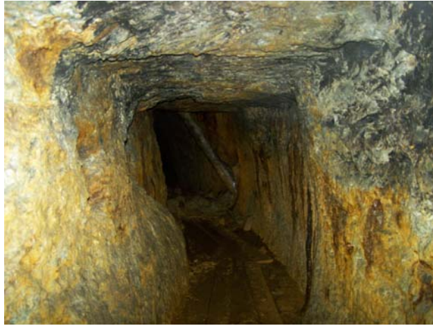
Rys. 7. Ręcznie wydrążone wyrobisko pochodzące z XVII wieku (fot. W. Mišta) Fig. 7. Hand-made adit from 17th century (photo: W. Mišta)
