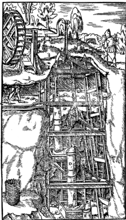
Szyb A. Najniższa pompa B. Pierwszy zbiornik C. Druga pompa D. Drugi zbiornik E. Trzecia pompa F. Koryto G. Żelazo przymocowane do wału H. Pierwsze szerokie cięgło. Drugie szerokie cięgło K. Trzecie szerokie cięgło L. Pierwsze okrągłe cięgło M. Drugie okrągłe cięgło N. Trzecie okrągłe cięgło O. Małe osie P. Notycia Q.
