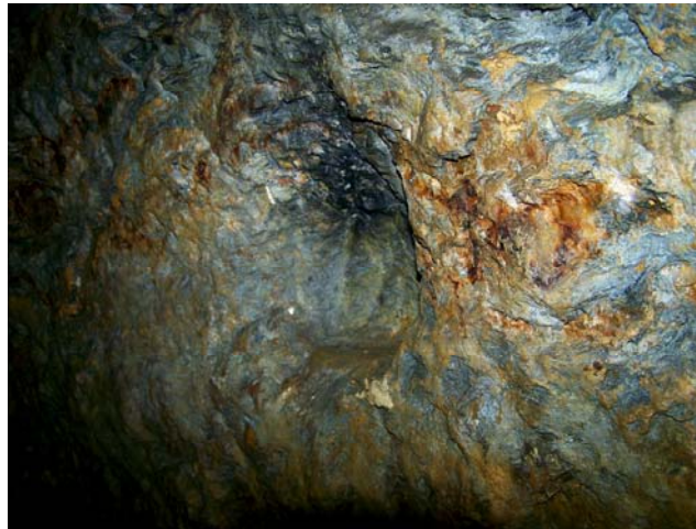
Rys. 8. Wnęka w której stawiano kaganki górnicze Fig. 8. Cavity for miners cresset (photo: W. Mišta)
