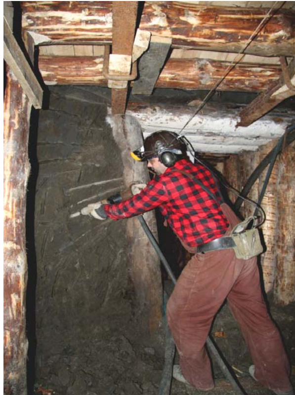
Ryc.12. Przybierka ociosu młotkiem pneumatycznym w trakcie wymiany obudowy w poprzeczni Karolina poziom II niższy (fot. W. Wiewiórka)
