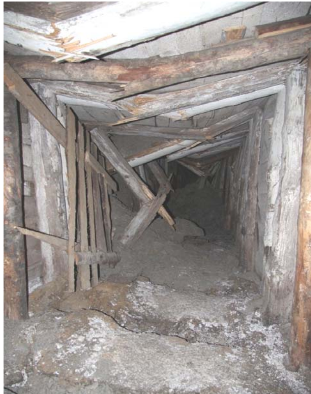
Ryc. 8. Zniszczona obudowa drewniana podłużni Lobkowicz – poziom II niższy (fot. W. Wiewiórka)
