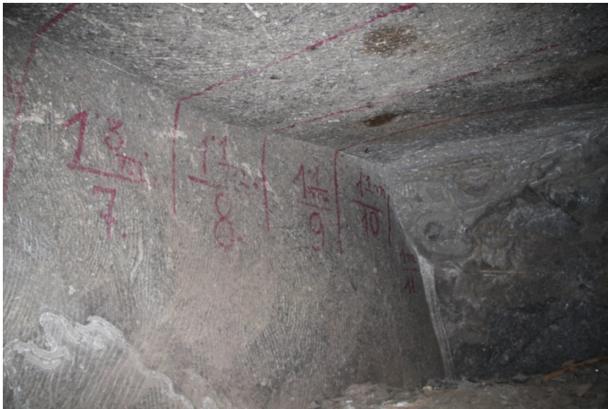
Ryc. 4. Ślady odbiórek postępu prac eksploatacyjnych w komorze przy podłużni Franciszek 1 – poziom II niższy (fot: W. Wiewiórka)
