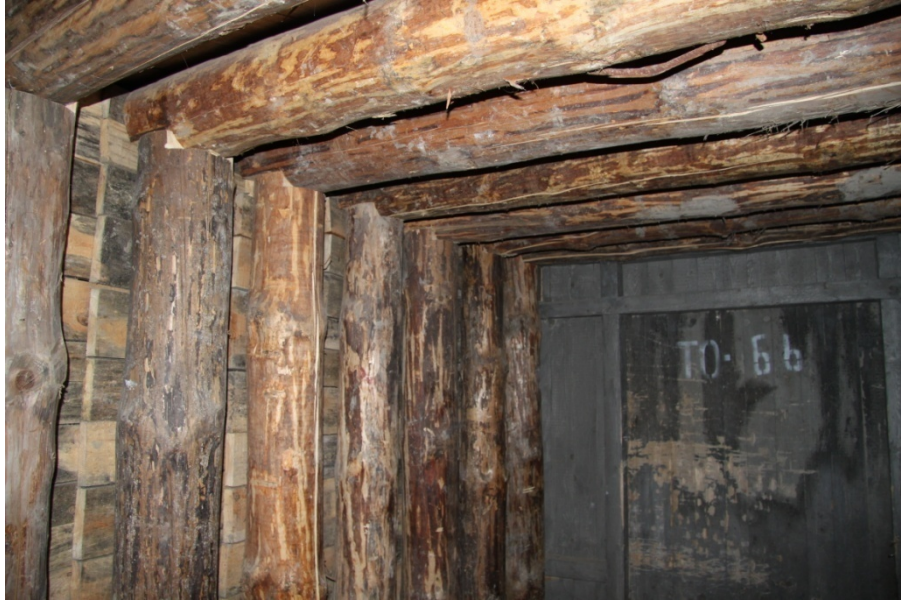
Ryc. 11. Obudowa drewniana z połączeniem stropnicy ze stojakiem na zamek niemiecki w wersji wielickiej w chodniku Bąkle poziom I (fot. W. Wiewiórka)
