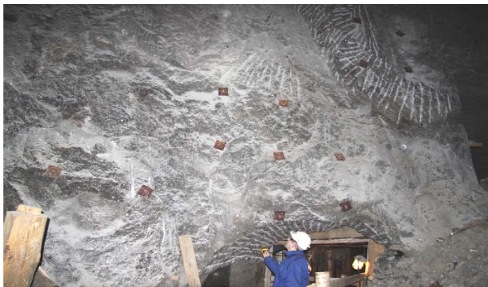
Ryc. 10. Zabezpieczony ocios komory Franciszek Karol na poziomie II niższym (fot. W. Wiewiórka)
