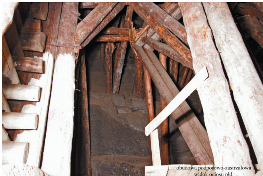
Rys. 9. Wysoka część komory – obudowa podporowo-zastrzałowa – widok ociosu południowego (Lasoń A.)
