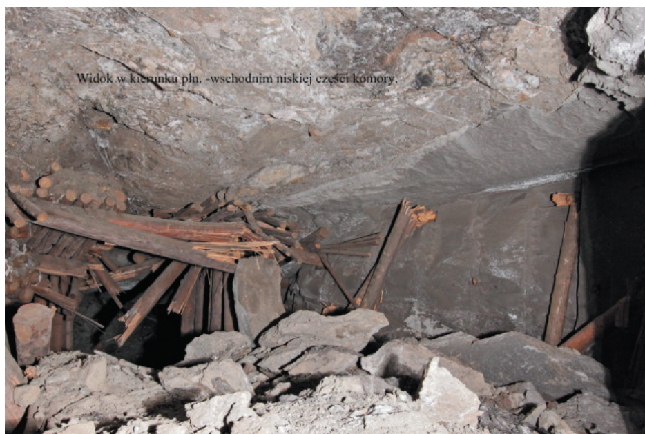
Rys. 5. Niska część komory – widok w kierunku północno-wschodnim (Lasoń A.)
