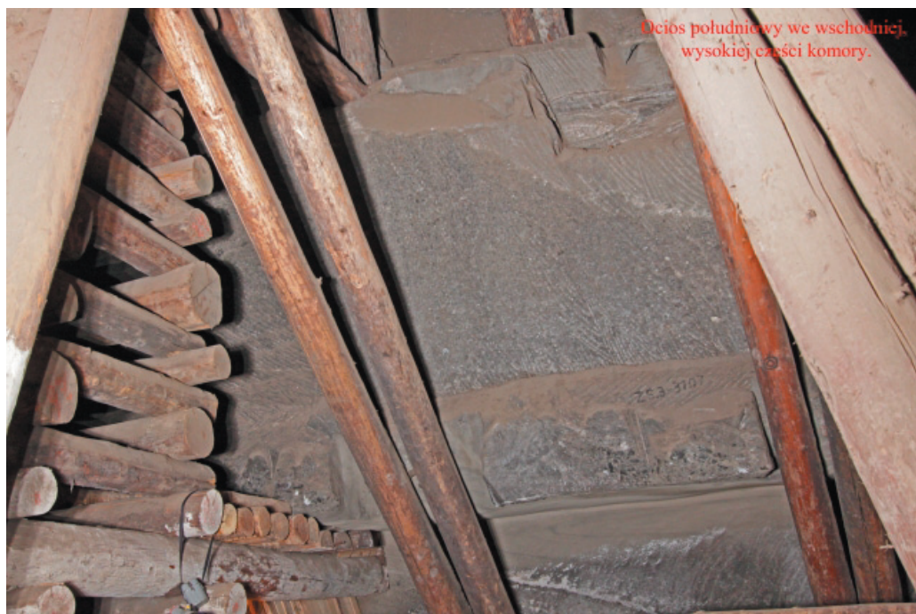
Rys. 12. Wysoka część komory – obudowa podporowo-zastrzałowa – widok ociosu południowego we wschodniej części komory (Lasoń A.)
