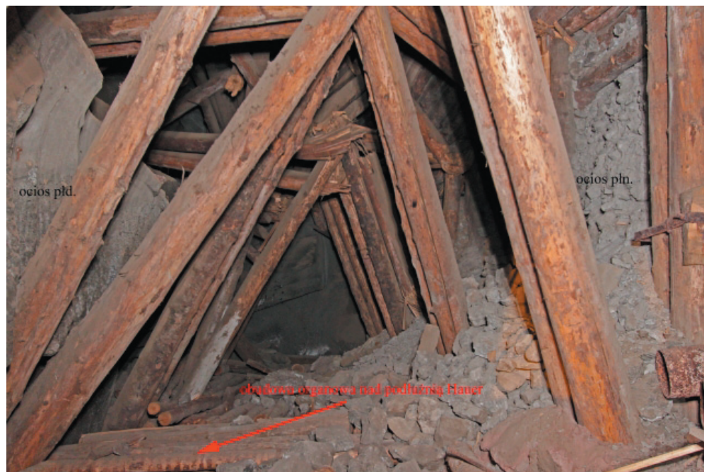
Rys. 8. Fragment obudowy podporowej w komorze Gaisruck nad podłużną Hauer (Lasoń A.)
