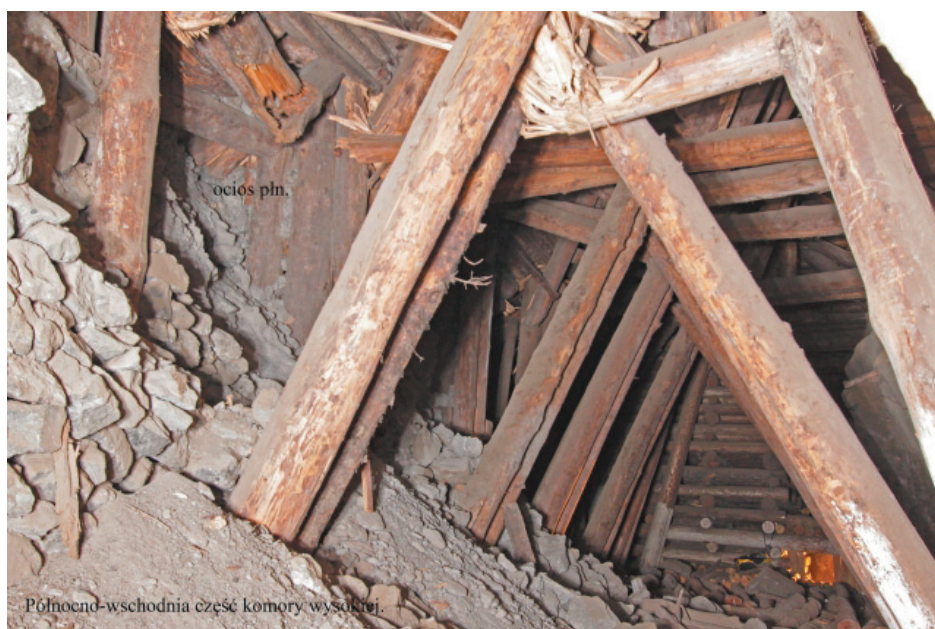
Rys. 11. Wysoka część komory – obudowa podporowo-zastrzałowa – widok w kierunku północno-wschodnim (Lasoń A.)
