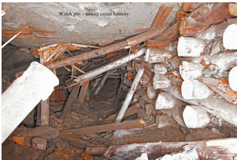
Rys. 4. Niska część komory – widok w kierunku północnym (Lasoń A.)
