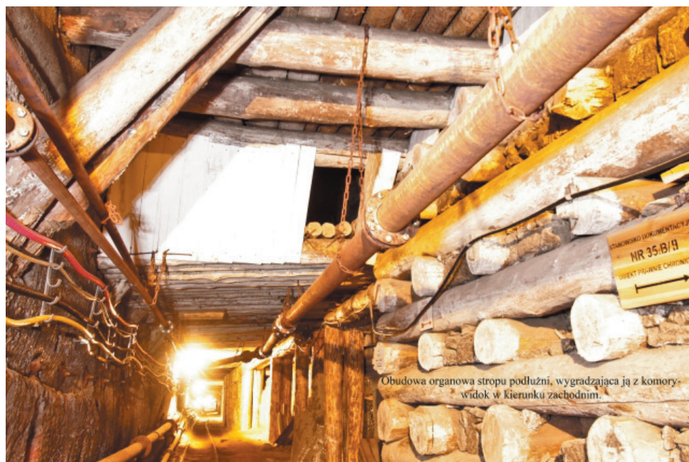
Rys. 7. Obudowa organowa podłużni Hauer nad przejściem pod wysoką częścią komory (Lasoń A.)
