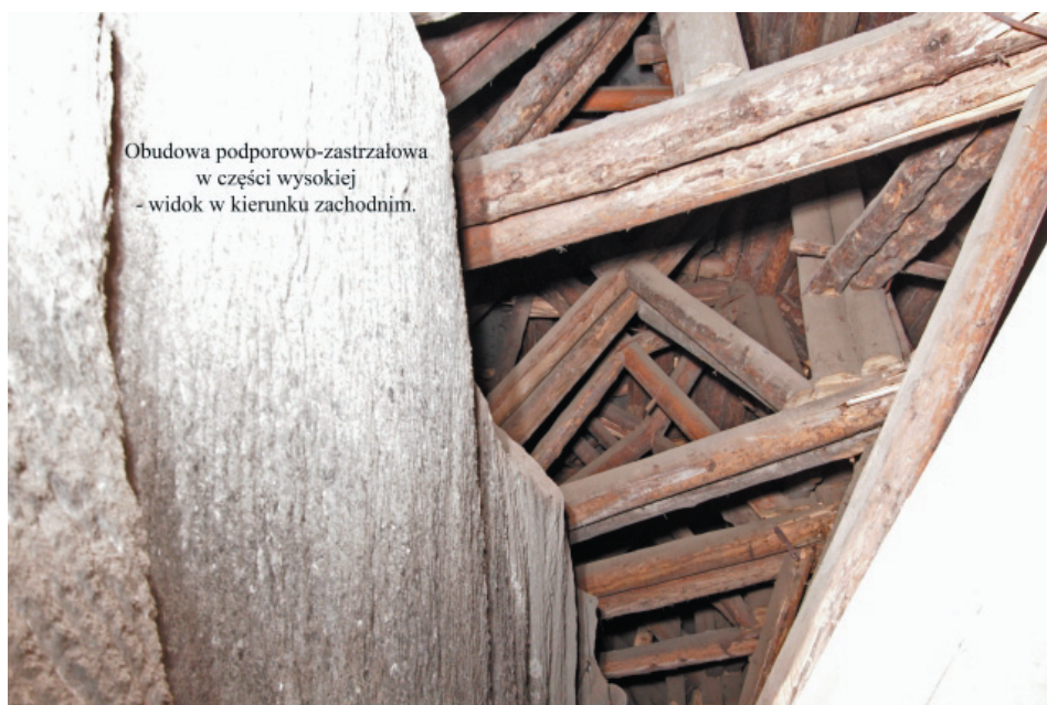
Rys. 10. Wysoka część komory – obudowa podporowo-zastrzałowa – widok w kierunku zachodnim (Lasoń A.)
