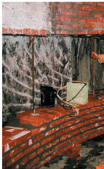
Rys. 5. Budowa obudowy wstępnej murowej
