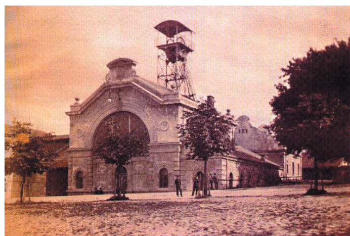
Rys. 10. Nadszybie Regis (fot. Jadwiga Machowiczowa, ok. 1913 r.) (Ochniak 2003)
