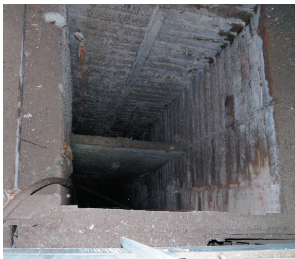
Rys. 6. Obudowa drewniana szybu Regis poniżej poziomu IV
