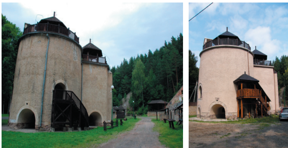
Rys. 2. Bliźniacze piece wapiennicze w Leszcznie przed i po renowacji (fot. M. Kobylańska)
