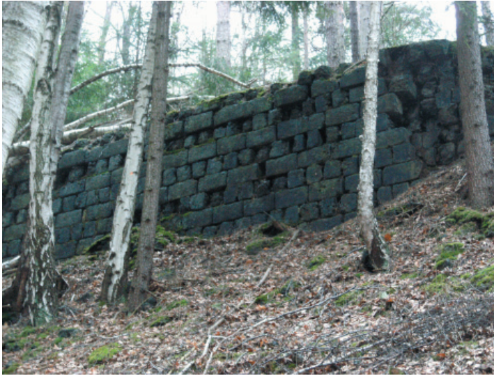
Rys. 4. Mur z prefabrykatów żużlowych (fot. M. Madziarz)
