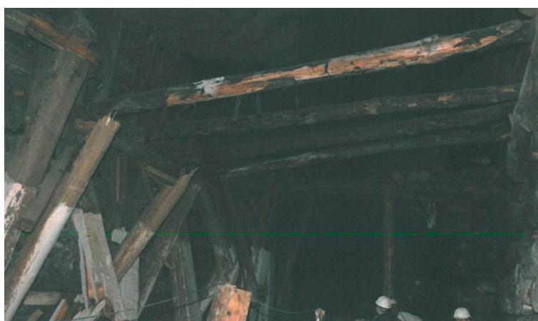
Rys. 4. Poziomo zabudowane okraglaki w celu ograniczenia wypychania ociosu do wnętrza komory (Parchanowicz i in., 2009)
