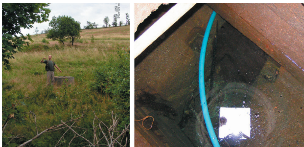
Rys. 16. Betonowa studzienka (ujęcie wody) i widoczny od góry, w jej wnętrzu, wlot sztolni (uwagę zwracają wykute w skale gniazda dla drewnianej stropnicy)
