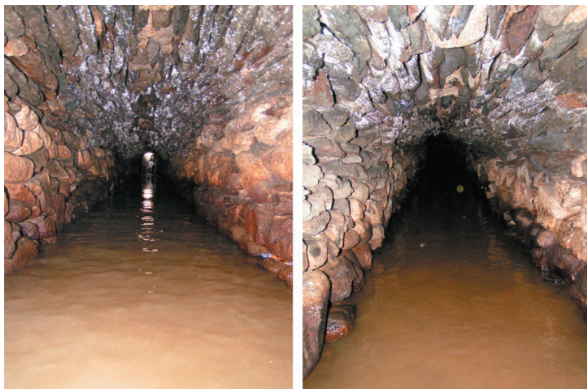
Rys. 14. Obudowa kamienna „Śląskiej Sztolni Szczęśliwej”
