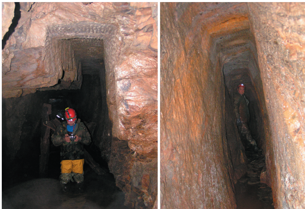
Rys. 7. Początkowy odcinek sztolni „Drei Brüder” zniszczony w wyniku powojennych robót poszukiwawczych (w wyrobisku M. Józków) oraz zachowana część wyrobiska z XVI w. (wewnątrz autor)
