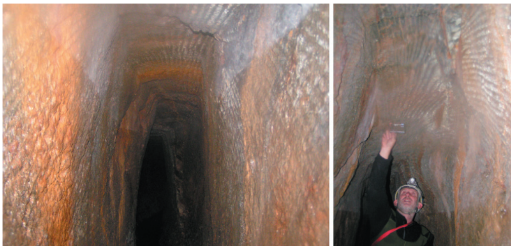
Rys. 8. Początkowy odcinek sztolni „Drei Brüder”, wykonany w 2. poł. XVI w. nosi niezwykle wyraźne ślady urabiania skał wyłącznie przy użyciu prostych narzędzi ręcznych (w wyrobisku M. Stajszczyk)
