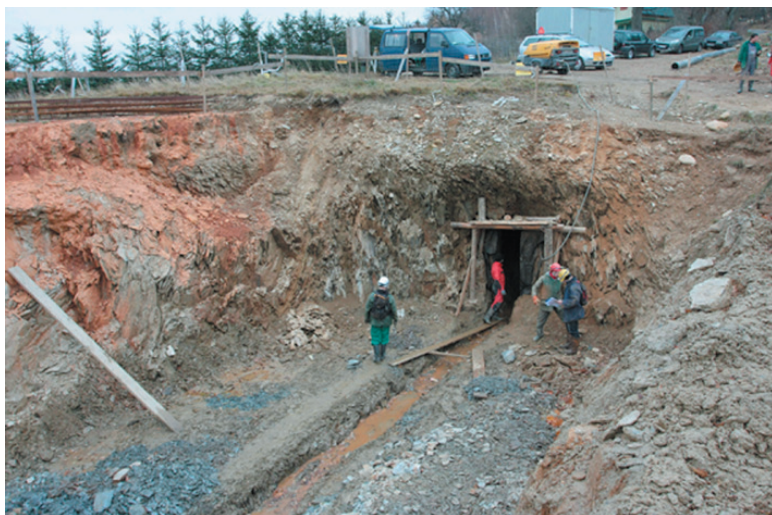
Rys. 12. Odkopany wlot sztolni „Sct. Leopold” w Krobicy
