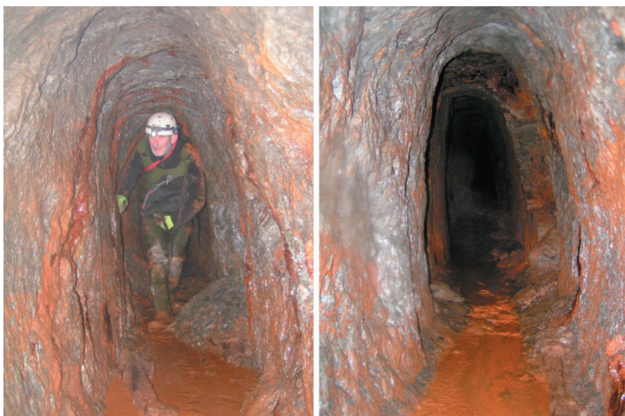
Rys. 9. Końcowy odcinek sztolni „Drei Brüder” ma odmienny kształt przekroju poprzecznego i nosi ślady urabiania skał za pomocą materiałów wybuchowych (w przodku wyrobiska M. Stajszczyk)
