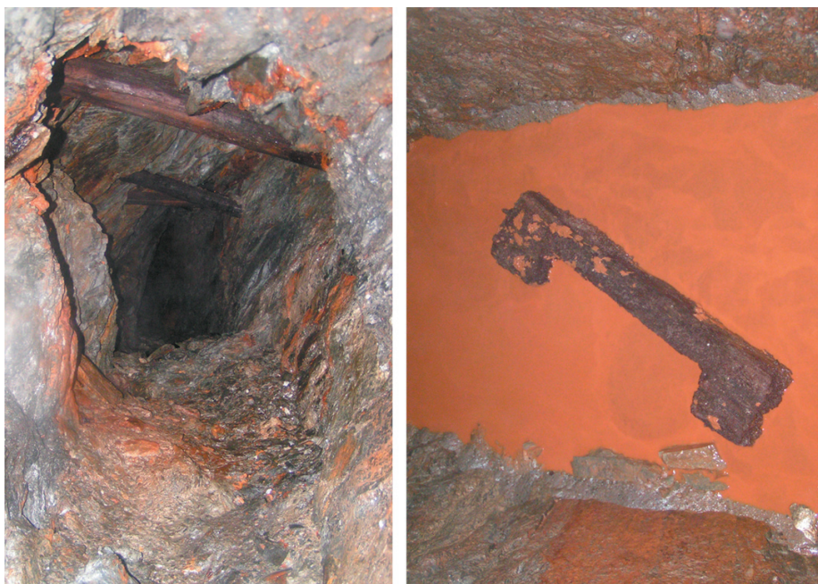
Rys. 10. Boczny chodnik wybierkowy w końcowym odcinku sztolni oraz zachowana drewniana podpora pomostu ułożonego niegdyś na spągu wyrobiska
