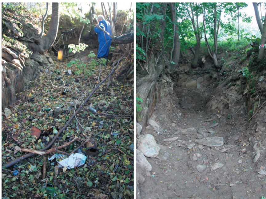
Rys. 4. Wypełniony odpadami wkop (roznos) mieszczący wlot sztolni „Drei Brüder” w Przeczniczy i ten sam obiekt po ich usunięciu
