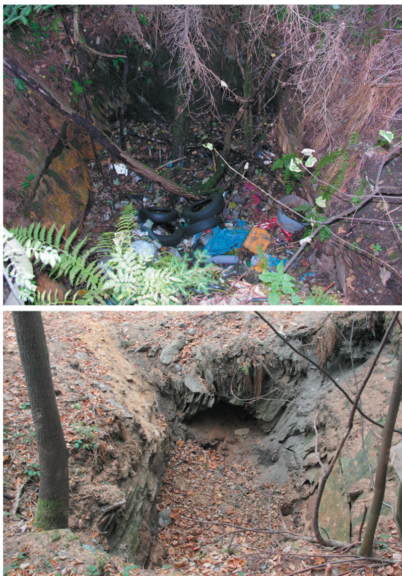
Rys. 5. Wypełniony odpadami wlot szybu kopalni „Hundsrückken” (XVIII w., po 1945 szyb nr 2 kopalni „Gierczyn”) i ten sam obiekt po ich usunięciu
