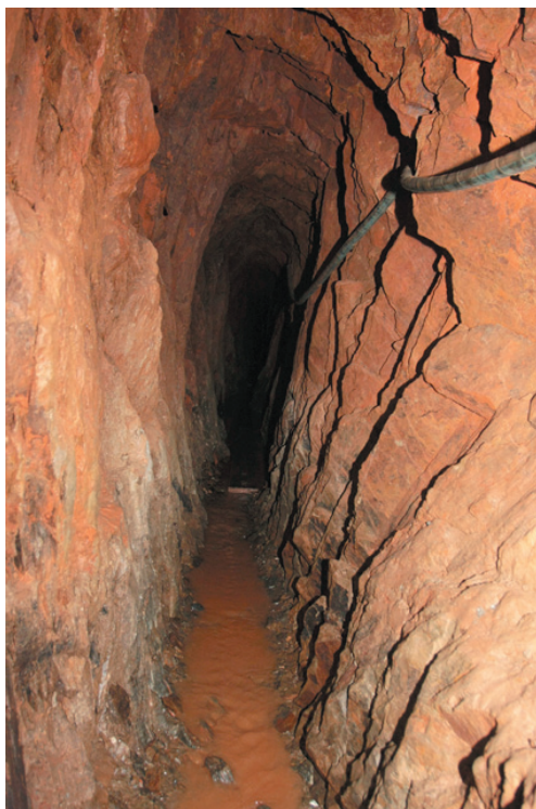
Rys. 3. Charakterystyczny, wąski kształt przekroju poprzecznego adaptowanej na potrzeby podziemnej trasy turystycznej sztolni „Św. Leopold” w Krobicy
