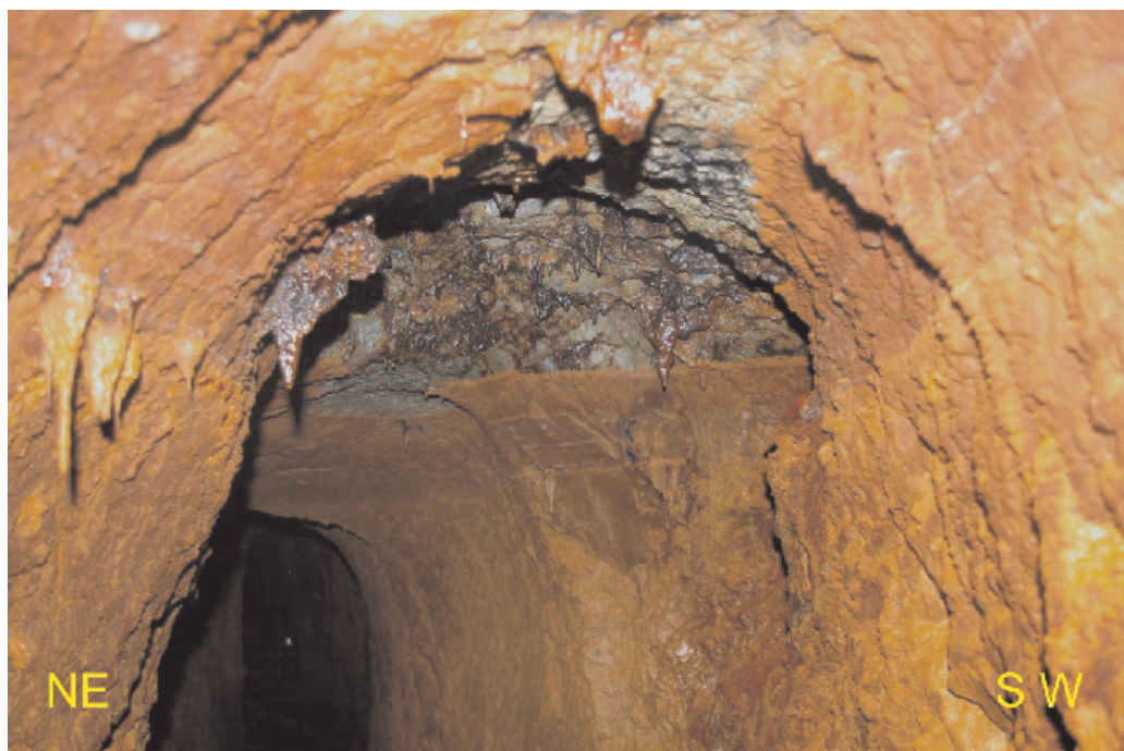
Rys. 3. Niemal całkowite zakrycie ociosów i stropu sztolni Leopolda warstwą wodorotlenków żelaza oraz żelaziste nacieki. (stan aktualności: 2010r.; Zagożdżon & Zagożdżon, 2010)
