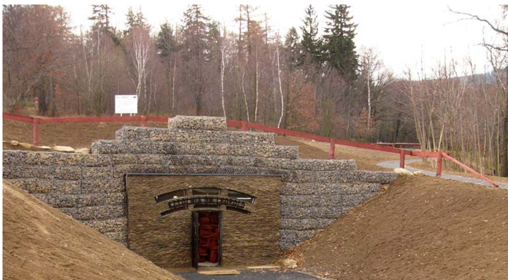
Rys. 2. Wejście do trasy podziemnej „Kopalnia Św. Jan” w Krobicy (fot. M. Kobylańska) Fig 2. The entrance to the underground track „St. Johannes” Mine in Krobica (photo M. Kobylańska)
