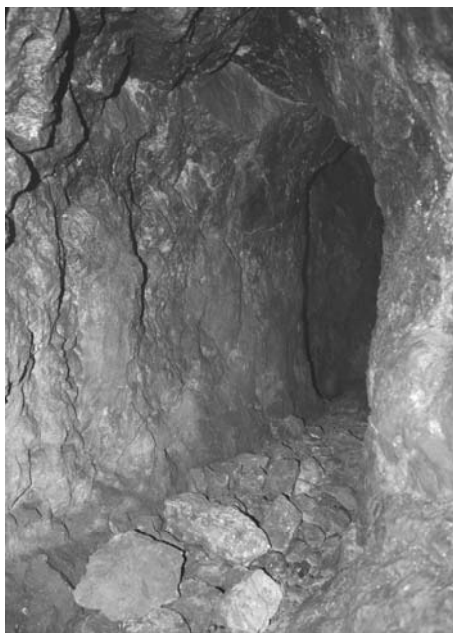
Rys. 6. „Partie kagankowe” – na lewym ociosie u góry kilka zagłębień – półki na kaganki łojowe na wysokości oczu kłęczącego człowieka Fig. 6. Parts „with lamps” – top on left some hollows – sebaceous lamp shelves on the eyes height of a kneeling man
