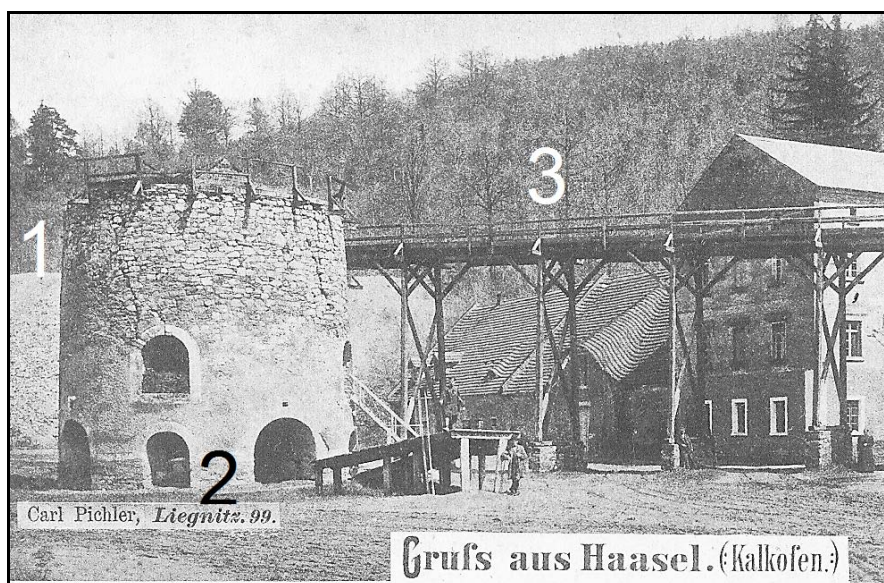
Rys. 8. Bliźniacze piece wapiennicze w Leszczynie wg widokówki z 1902 r. 1 – świeża hałda u wylotu sztolni Heinrich, 2 – wapienniki, 3 – pomost do dostarczania kamiennego wsadu do pieców (wg pocztówki z kolekcji L. Karlaka)
