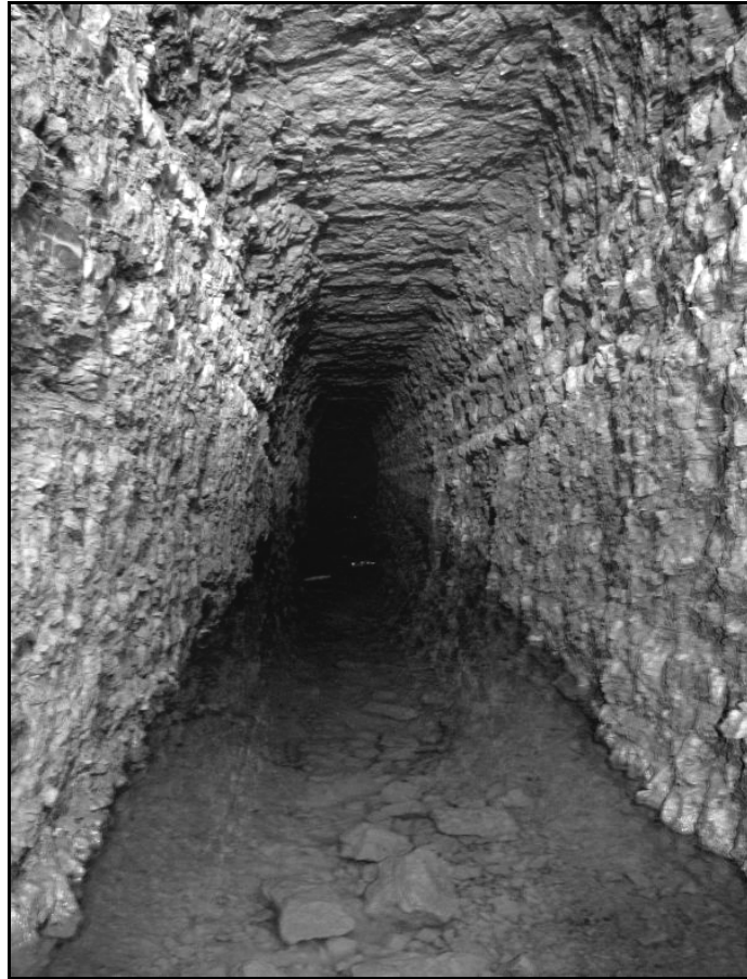
Rys. 9. Nieznana sztolnia poszukiwawcza pod Biegoszowem, w spągu zalana wodą (fot. W. Dmitrowski)
