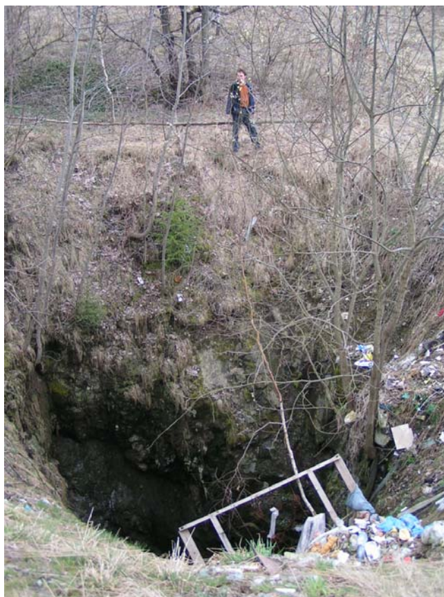
Rys. 3. Niezabezpieczony, wykorzystywany jako nielegalne składowisko odpadów, dawny szyb w Ciechanowicach (fot. A. Madziarz)
