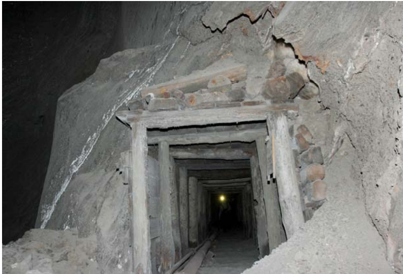
Rys. 3. Podłużnia Król Saski w części zachodniej. Wlot do komory bez nazwy Fig. 3. The chambers 'no name' entryway. West Saski Kings' gallery
