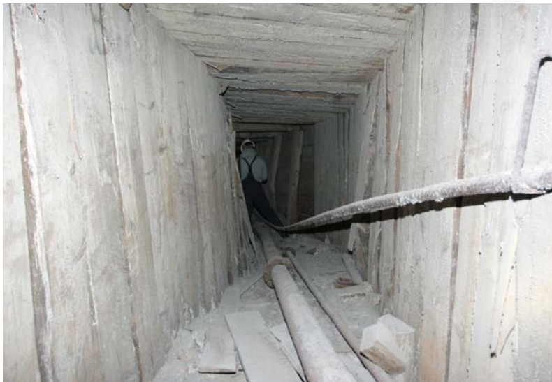
Rys. 4. Podłużnia Król Saski przed wlotem do komory Orzechowski Fig. 4. The Saski Kings' gallery prior to the entryway of Orzechowski' chamber
