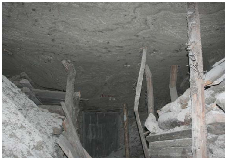
Rys. 5. Przejście podłużni Król Saski przez komorę Orzechowski Fig. 5. The Orzechowski' chamber and the Saski Kings' walkway gallery through
