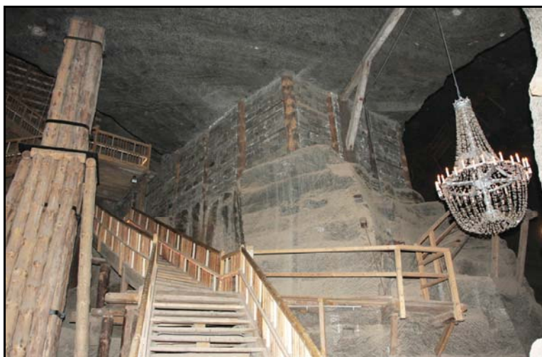
Rys. 4. Filar i wiązka stojaków drewnianych w środkowej części komory Saurau (Adam Maj 2010) Fig. 4. The central pillar and wooden column in the middle of the Saurau chamber (Adam Maj, 2010).
