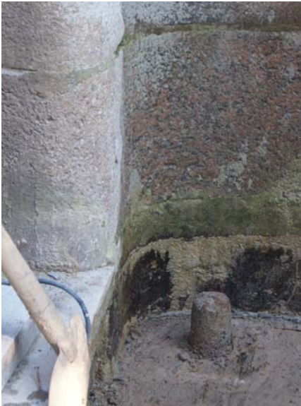
Rys. 6. Widok elementów żelaznych wytworzonych we wsi Huta; a) czop w dnie progu śluzy, b) okucie pała drewnianego Fig. 6. View of iron produced in the village of Huta; a) iron pin in the bottom of the lock threshold, b) ferrule wooden pile
