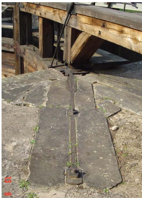
Rys. 7. Widok wstęp mocujących wrota: a) projekt wstęp, b) wstęga mocująca wrota w śluzie Perkuć Fig. 7. View of the gate fastening anchors a) anchor design b) clamping anchor in the lock gates Perkuć
