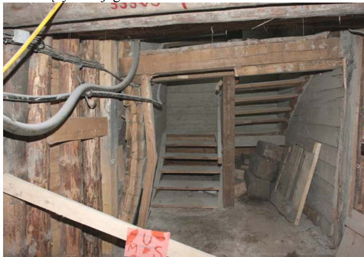
Rys. 3. Wyjście z szybika Koerber na poziom III
