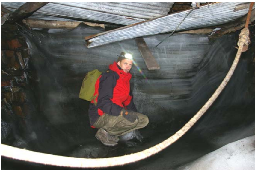
Rys. 4. Włot sztolni G2b–3 całkowicie wypełniony warstwowanym lodem (fot. K. Grudzińska)
