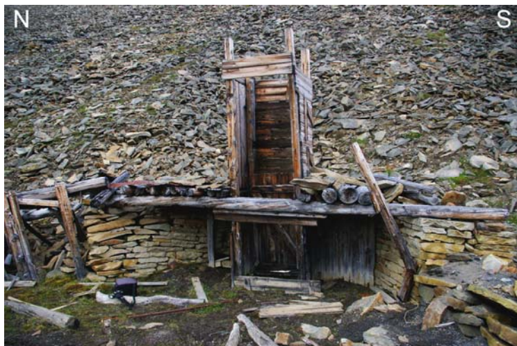
Rys. 6. Sztolnia G2–C, wysoka, drewniana konstrukcja zabudowana nad wlotem Fig. 6. Adit No G2–C with high, wooden construction above the entrance
