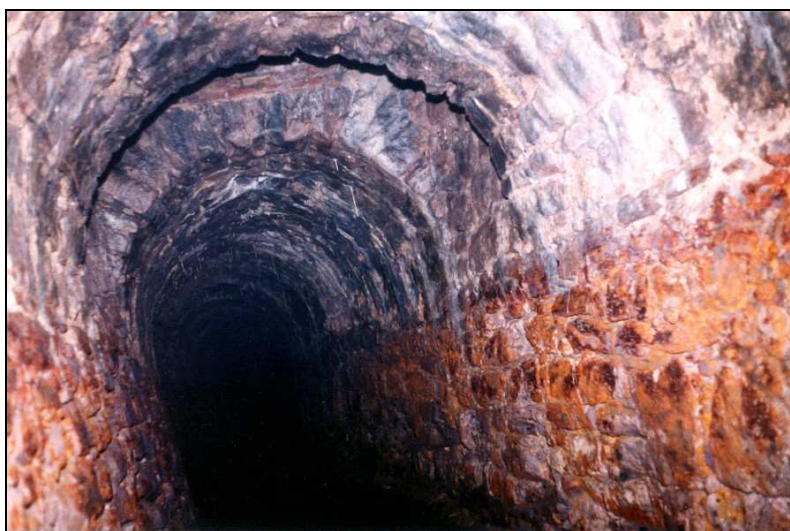
Fot. 7. Oryginalna obudowa kamienna w „Lisiej” sztolni Phot. 7. Original stone lining in Fox’s day level (adit)
