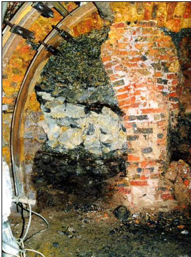
Fot. 6. Fragment dawnej obudowy murowej w sztolni Phot. 6. Fragment of former brick lining in adit
