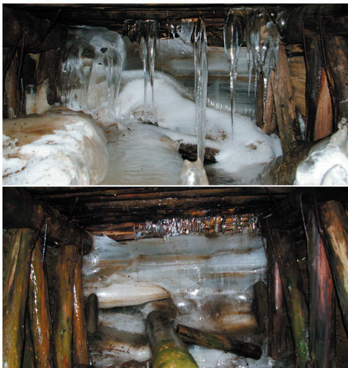
Ryc. 3. Warstwowy lód wypełniający dalszą część sztolni G1b-α na fotografiach z lat 2012 (u góry) i 2015 (na dole), zauważalne cofnięcie czoła lodowego wypełnienia wyrobiska
